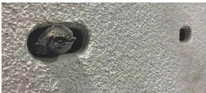
Hinter dieser kleinen Öffnung in der wärmegeämmten Fassade verbirgt sich ein in die Dämmung integrierter Nistkasten, der Vögeln, Fledermäusen oder Insekten einen Nistplatz bzw. einen Rückzugsort bietet.
