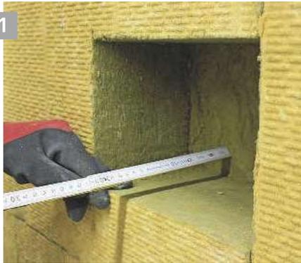
1 In die Dämmung des WDVS wird eine Öffnung mit den Abmessungen des jeweils gewünschten Kastens geschnitten.
