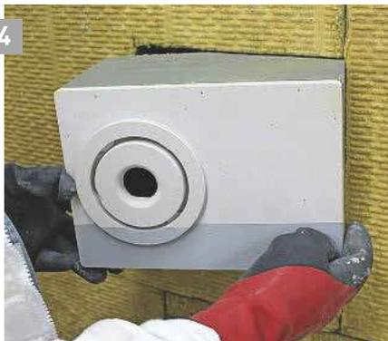
4 Der Nistkasten wird in die Dämmstofföffnung eingeschoben, bis er bündig zur Dämmstoffoberfläche sitzt.
