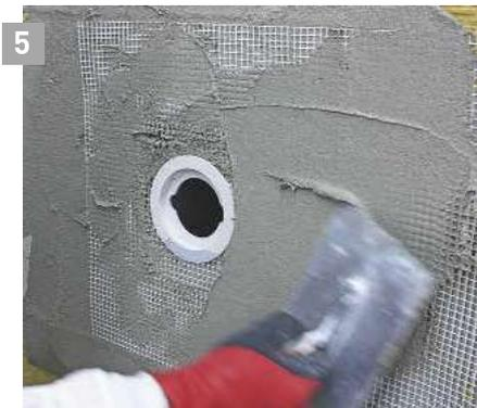
5 Das Armierungsgewebe ist passend ausgestanzt. Es wird in die Nut an der Einflugöffnung eingelegt und in den Armierungsmörtel eingespachtelt.
