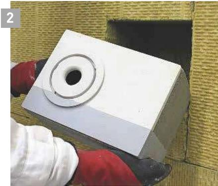
2 Der Nistkasten (hier einer für Meisen und Sperlinge mit abnehmbarer Reinigungsrosette) wird so eingebaut, dass die Abdichtung unten liegt.
