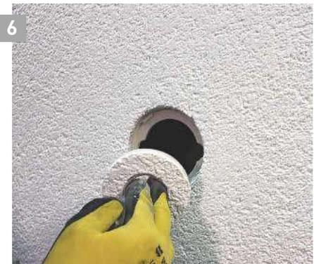
6 Abschließend wird der Oberputz aufgetragen. Bei dieser Kastenvariante muss noch die Reinigungsrosette eingesetzt werden.
