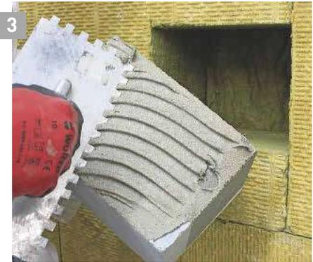
3 Die Verklebung im WDVS erfolgt mit Klebe- und Armierungsmörtel, der mithilfe einer Zahnkelle auf den Kasten aufgetragen wird.
