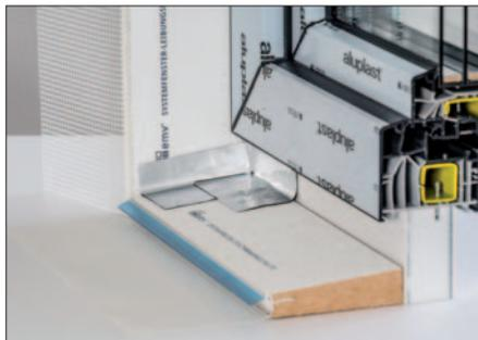
Montage du panneau en biseau avec deuxième niveau d'étanchéité.
