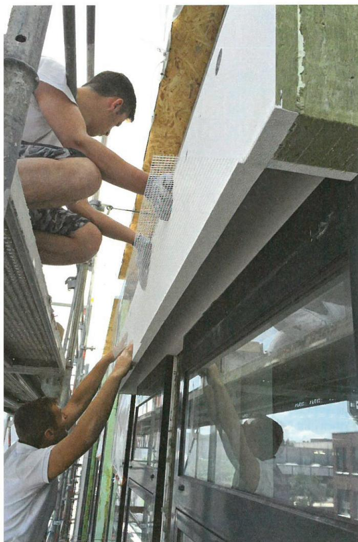
1 Einbau eines mit Steinwolle gedämmten Jalousienkastens.
