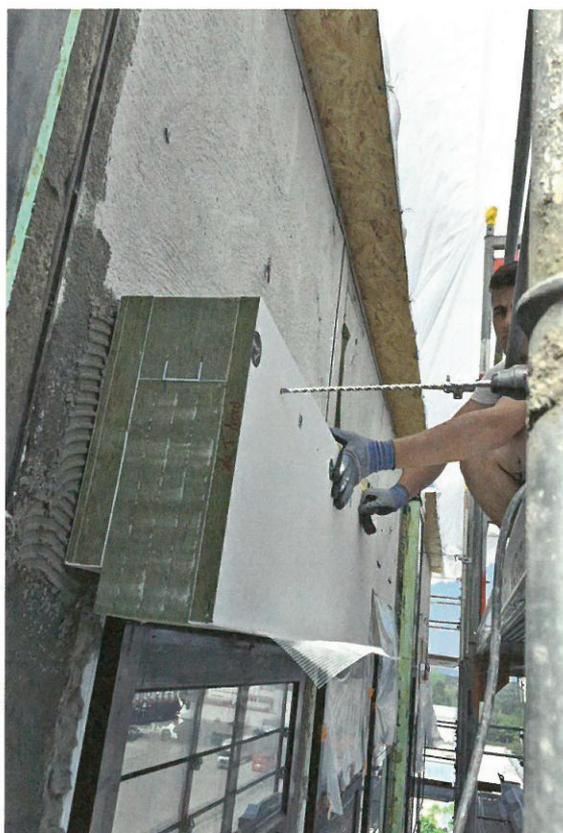
3 Verdübelung des mit Steinwolle gedämmten Jalousienkastens.
