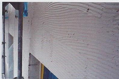
2 Mit einem aufgekämmten Haftspachtel wird der Untergrund für den Massivputz vorbereitet.
